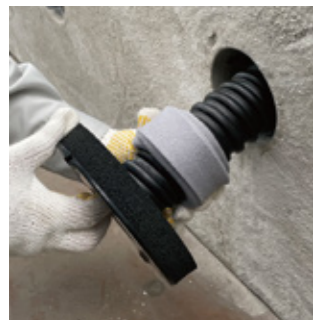
パッキンとスポンジの間を30mm確保し、 スポンジを引っ張りながら巻き付けます。
