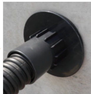
黄色パッキンが見えなくなれば 完了。(目安です)
