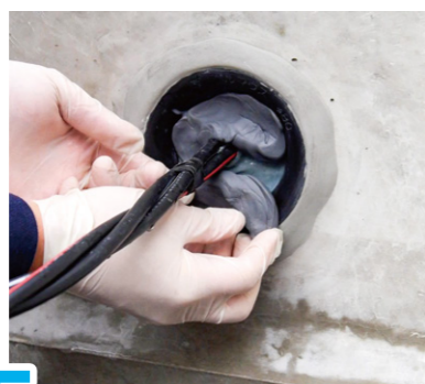
5 ネオシール施工中
