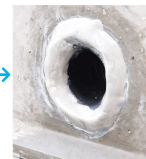
4 止水処理完了
