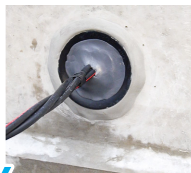
6 止水処理完了
