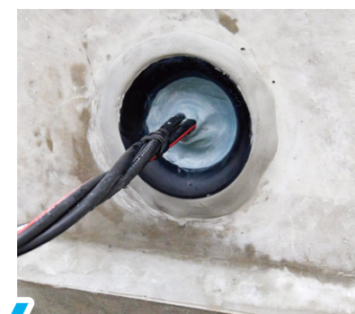
4 ミズストッパー施工完了
