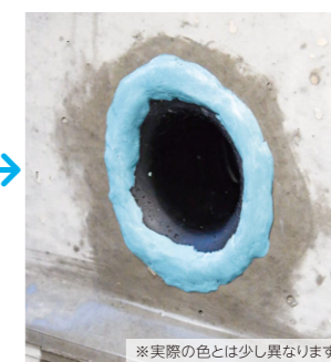
3 ミズストッパー施工完了
