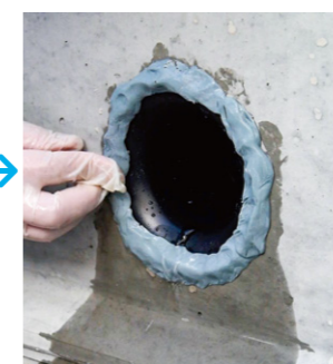
2 ミズストッパーを漏水箇所につめていく
