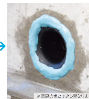
3 ミズストッパー 施工完了
