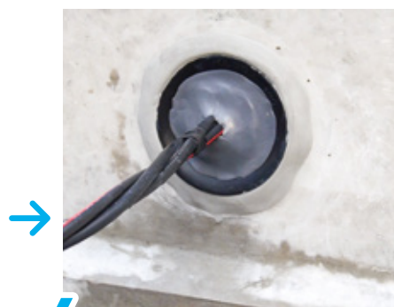
6 止水処理完了
