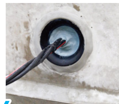
4 ミズストッパー施工完了
