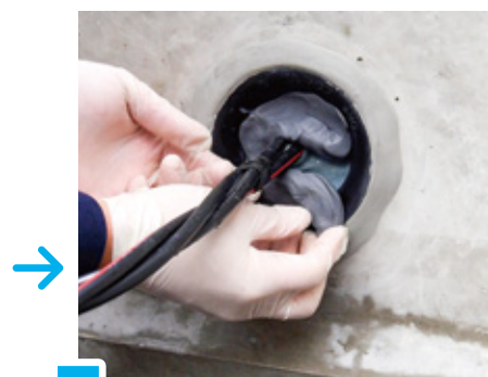
5 ネオシール施工中
