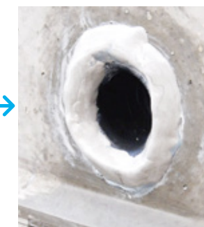
4 止水処理完了
